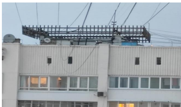
Рисунок 3 – Ограждение на кровле дома
